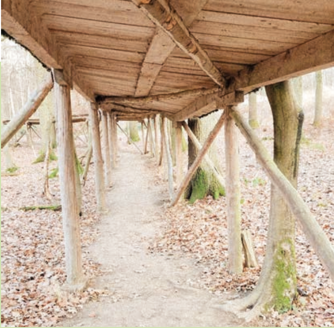
Der überdachte Allwetterweg
